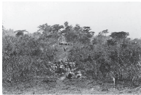
写真 2-8 開墾のための測量風景
