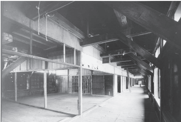
写真 2-64 5番蚕室 二階（平成13年保存修理前・南西より）
