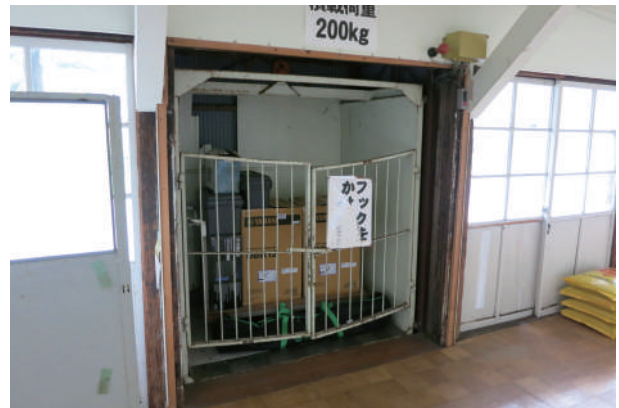
写真 2-46 3番蚕室 ②一階廊下リフト
