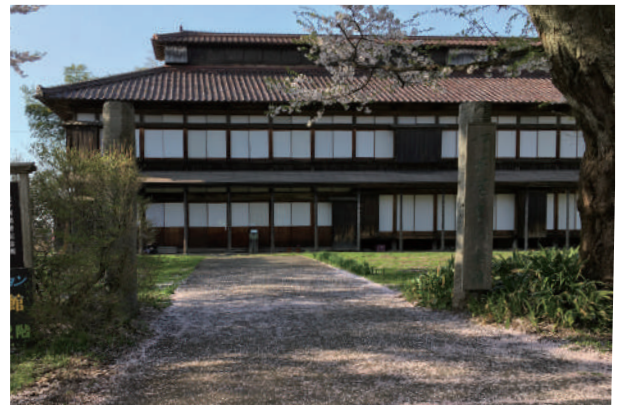
写真 2-27 1 番蚕室 外観（南より）
