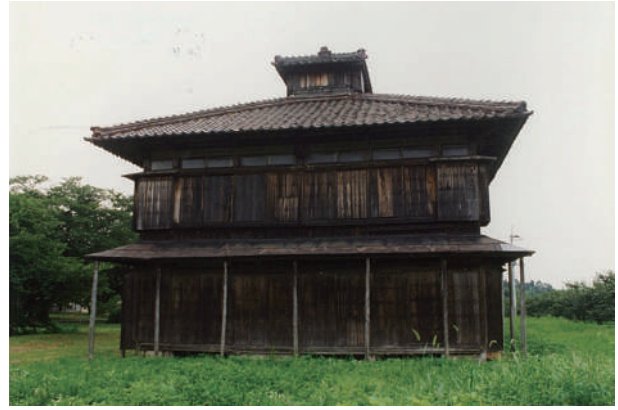
写真 2-61 5番蚕室 外観（平成13年保存修理前・東より）
