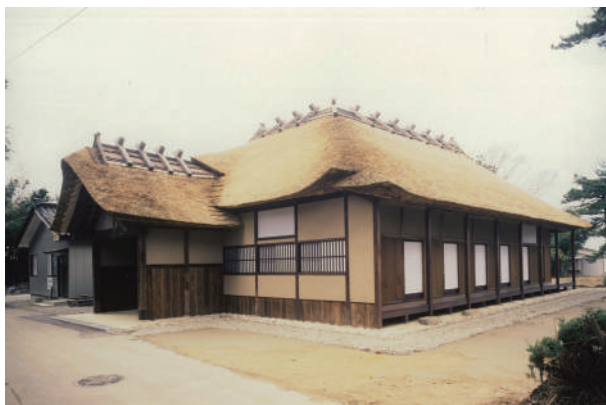
写真 2-23 本陣 外観（平成 12 年保存修理後・南東より）
