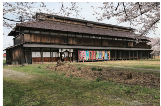
写真 2-59 5 番蚕室 外観 (南西より)
