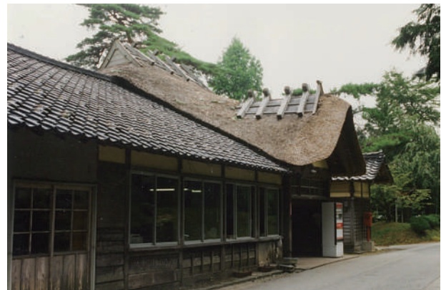
写真 2-22 本陣 外観（平成 10 年保存修理前・南西より） ※東側に旧事務所が接続している
