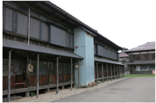
写真 2-42 3番蚕室 外観 (南西より)
