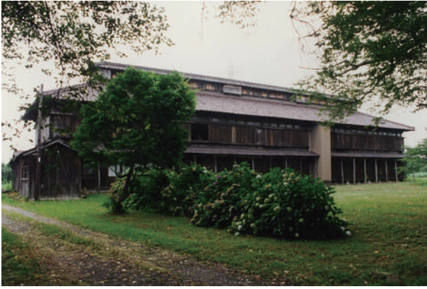
写真 2-60 5番蚕室 外観（平成13年保存修理前・南西より）
