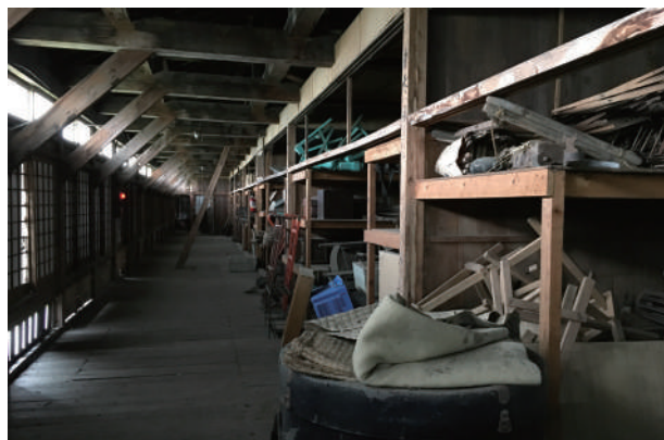
写真 2-56 4 番蚕室 ④農具資料保管状況
