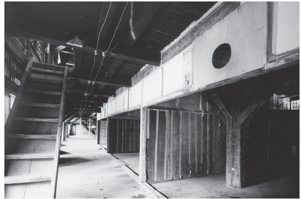
写真 2-63 5番蚕室 一階（平成13年保存修理前・南東より）
