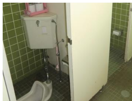
体育施設のトイレを洋式化
