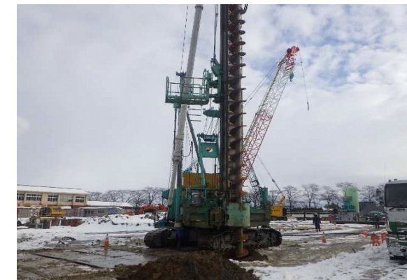
杭打機(2号機)杭施工状況
