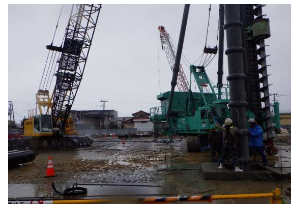
杭打機(1号機)の杭施工状況
