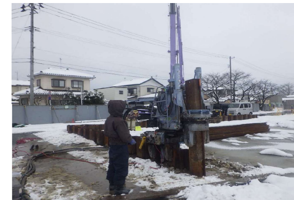
土止め矢板施工状況
