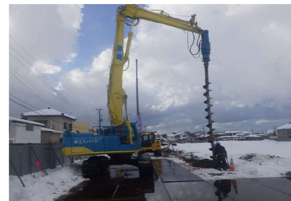
土止め工事矢板先行削孔状況
