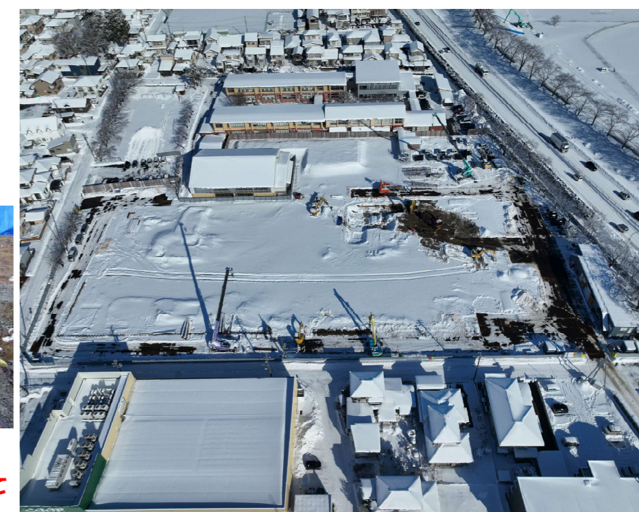
土工事開始状況を上空から撮影した写真です。
