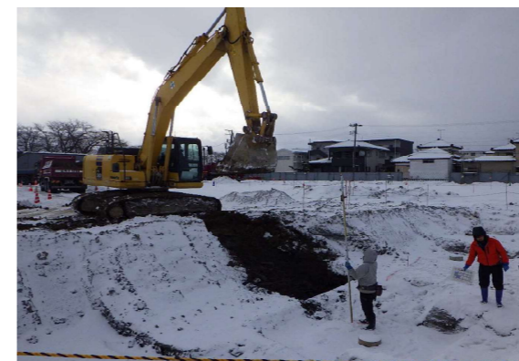
土工事掘削状況(運動場棟)
