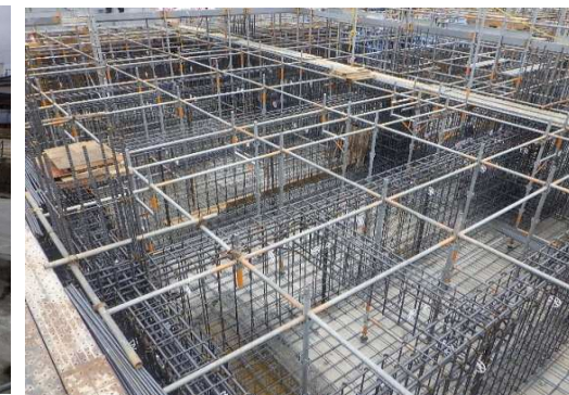
A棟基礎配筋状況
