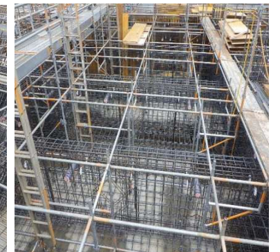
A棟型枠組立状況
