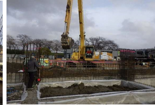
C棟埋戻し状況
