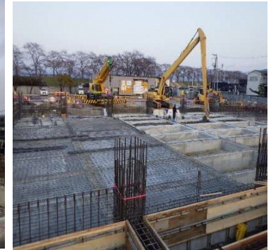
C棟土間配筋状況
