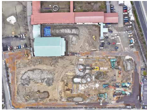
令和5年1月中旬時点 (プールと小体育館を先行解体しつつ掘削工事)
