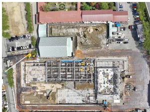
令和5年4月末時点 (杭工事が完了し、現在屋内運動場先行でコンクリート工事が進められています)
