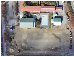
令和4年10月時点 (工事準備が始まった頃)
