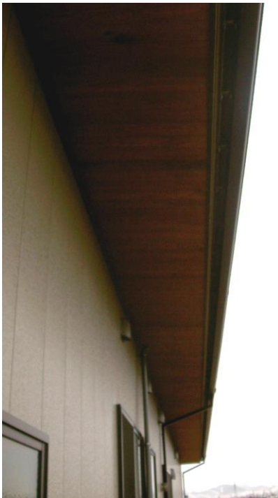
建物を風雪から守る 幅の広い軒の張り出し
