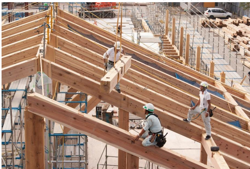
朝日中学校建設 状況
