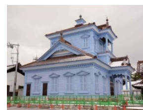
同上(竣工 H30)
