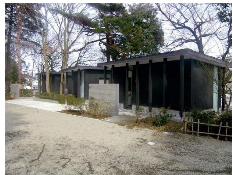
鶴岡公園公衆トイレ改築
