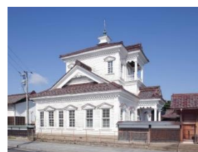
旧鶴岡警察署庁舎外景 (修理前 H25)
