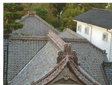
御隠殿 屋根瓦外観修景後
