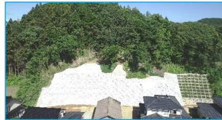
☆土砂災害 対策工事☆
