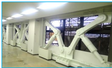
☆鶴岡市役所 耐震補強工事☆
